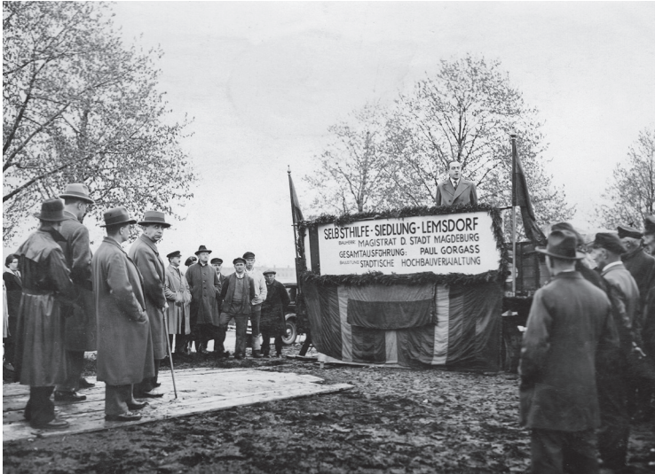
Erster Spatenstich für die Selbsthilfe-Siedlung Lemsdorf bei Magdeburg, 10. Mai 1932.
